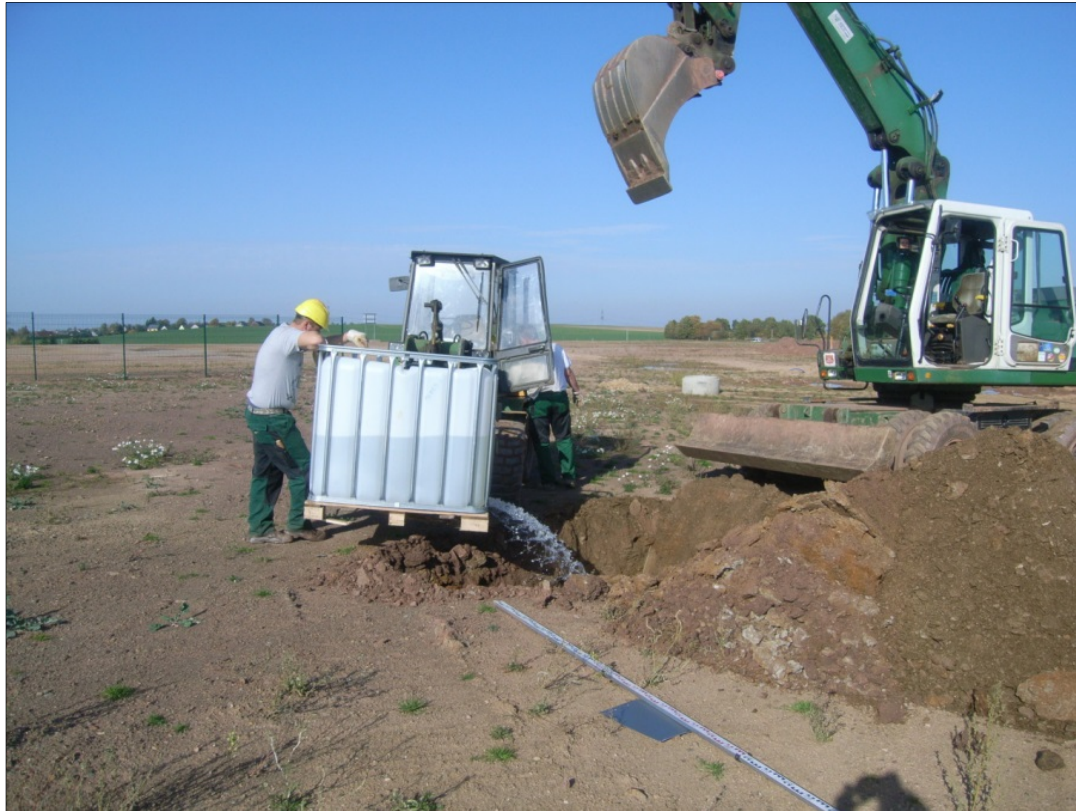
Bild 3: Beispiel für das Befüllen einer Schurfgrube
