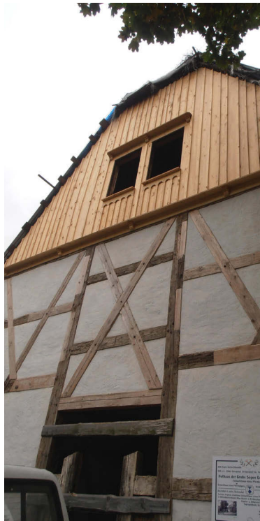
Wiederherstellung der Ständerkonstruktion des Nordgiebels 2011
