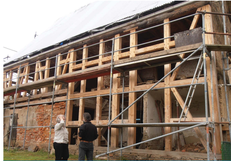
Wiederherstellung der Ständerkonstruktion an der Ostseite 2011
