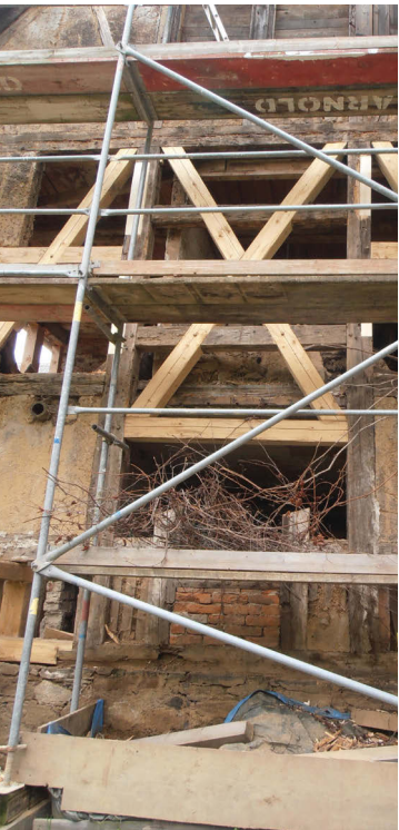
Wiederherstellung der Ständerkonstruktion des Nordgiebels 2011
