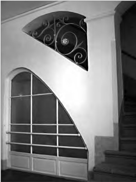
Barockes Treppenhaus Markt 4 (Foto: Andreas Teuchner)
