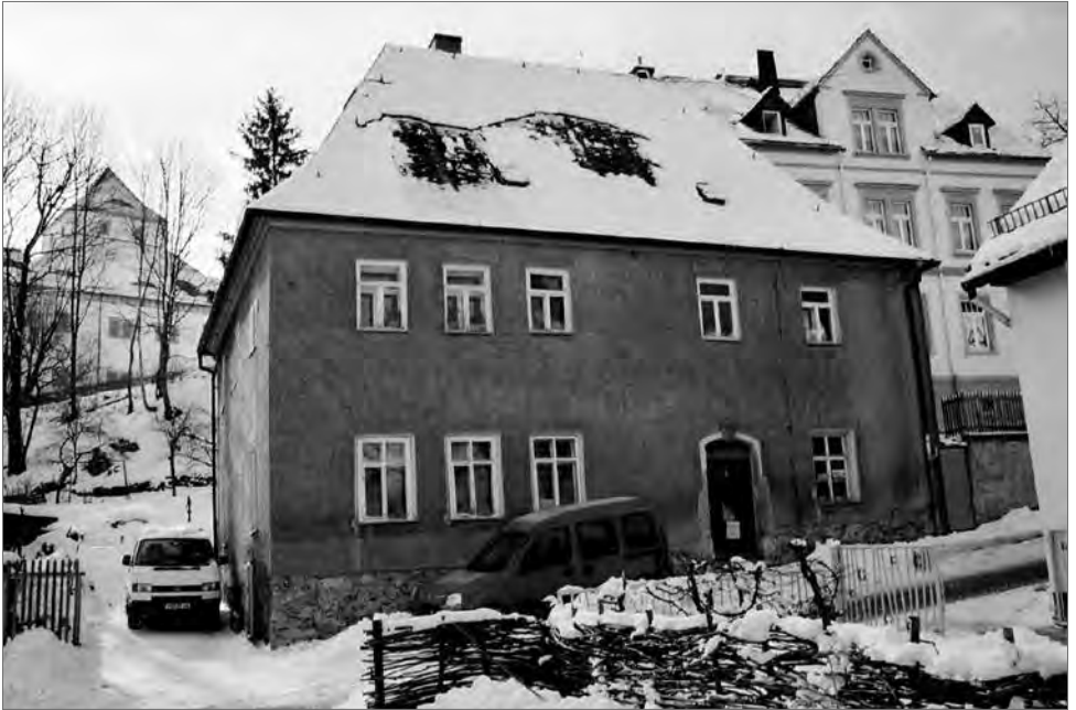
Das Gebäude Schlossstraße 3 vor Beginn der Restaurierung im Winter 2004; Foto: Martin Teller.
