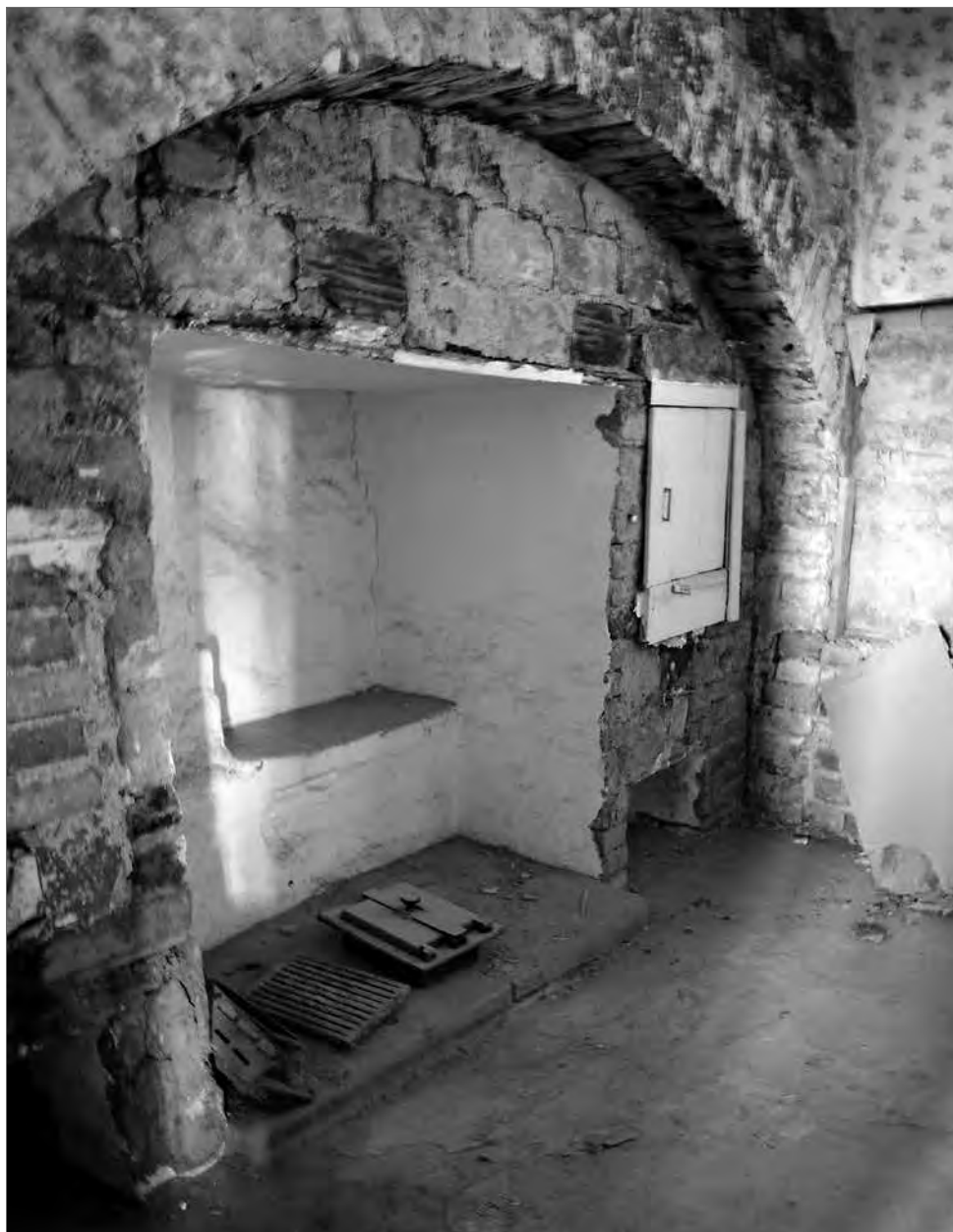
Im Bereich der einstigen Schwarzküche im Erdgeschoss befindet sich diese bemerkenswerte Bogenkonstruktion - Aufnahme 2017; Foto: Privatarchiv Familie Weber.
