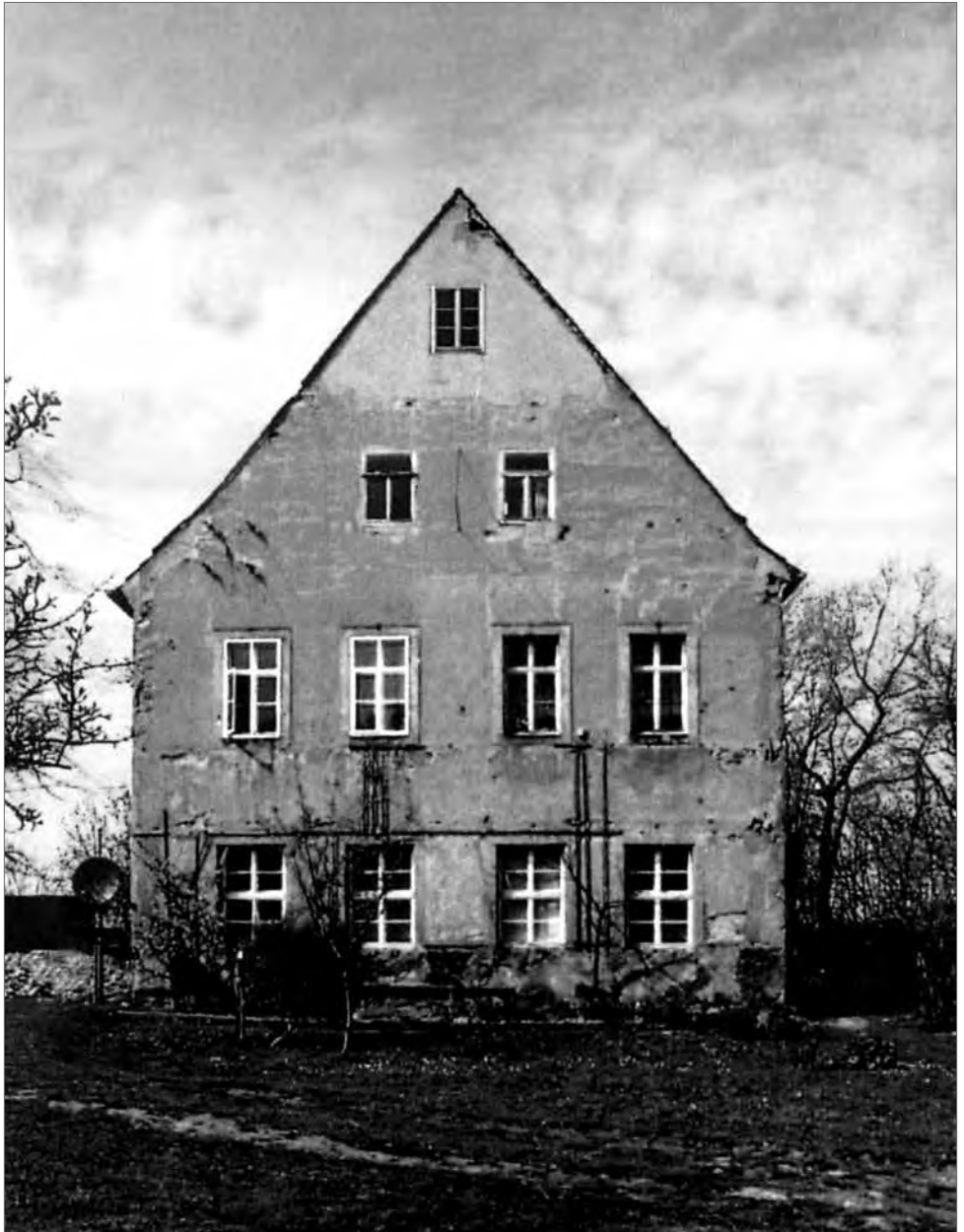
Ein schwieriger Start: Verbraucht und „in die Jahre gekommen“ zeigte sich das Bauwerk vor dem Beginn der Sanierungsmaßnahmen im Jahre 1994; Foto: Familienverband Spielhaus und Mittag.
