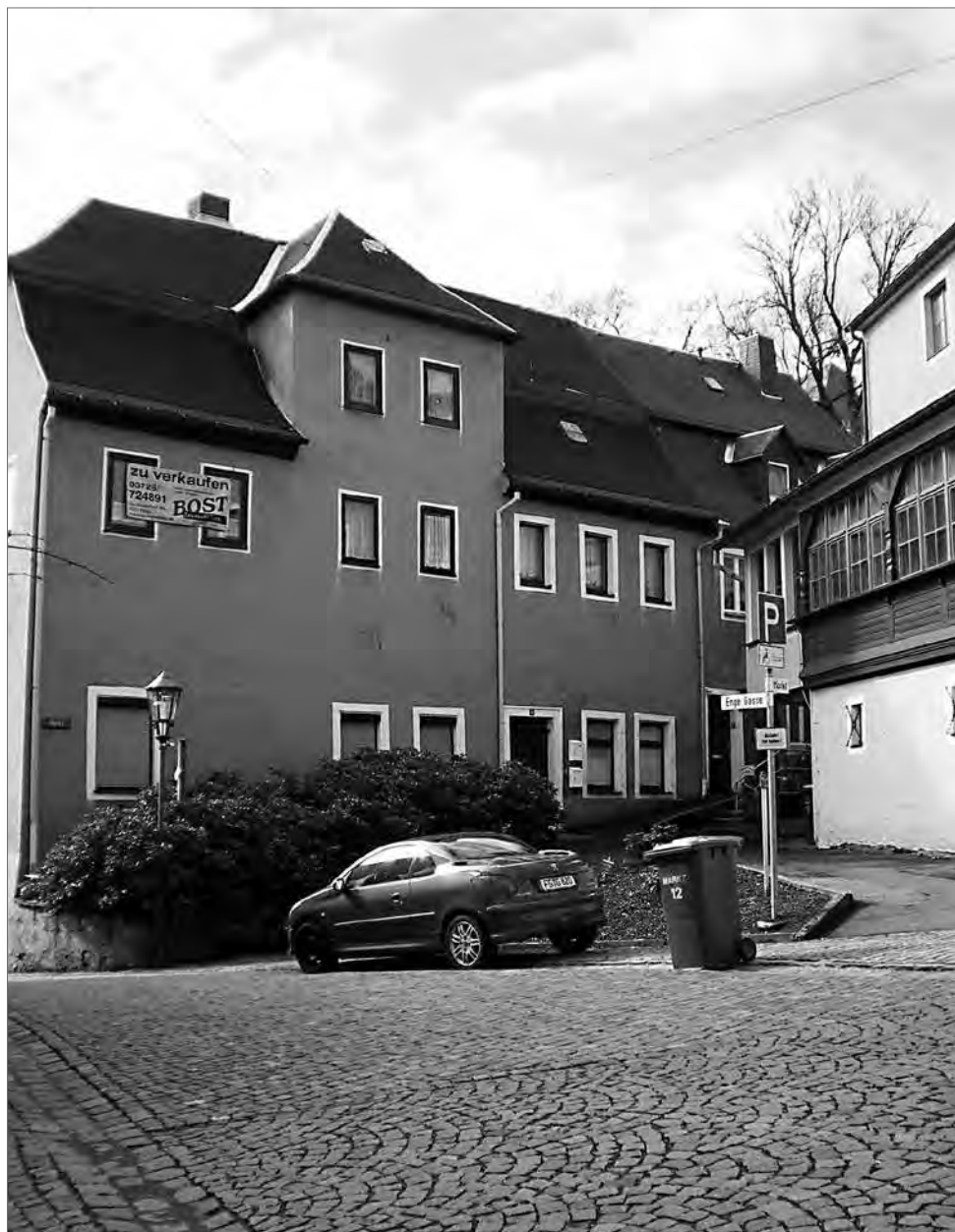
Hoffnung für das altehrwürdige Bauwerk durch einen Verkauf: Zustand Markt 10 im Jahre 1996; Foto: Archiv untere Denkmalschutzbehörde.
